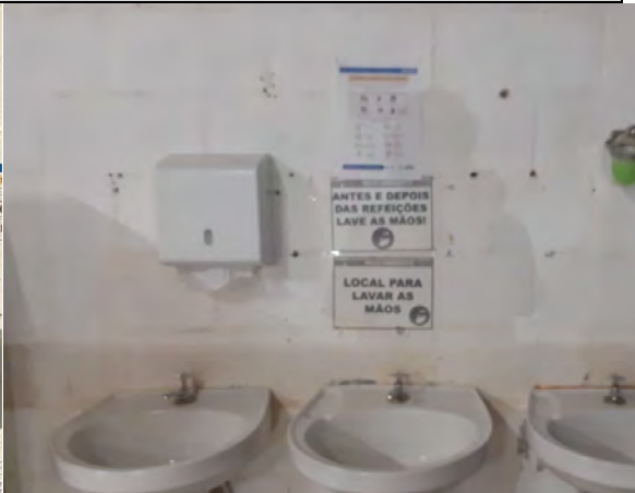
Foto 32 – Cartazes sobre o novo Coronavírus pelo canteiro industrial (21/03/20).
