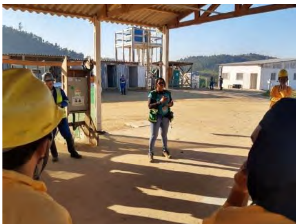
Foto 19 – Treinamento para atendimento a emergência ambiental (11/03/20).
