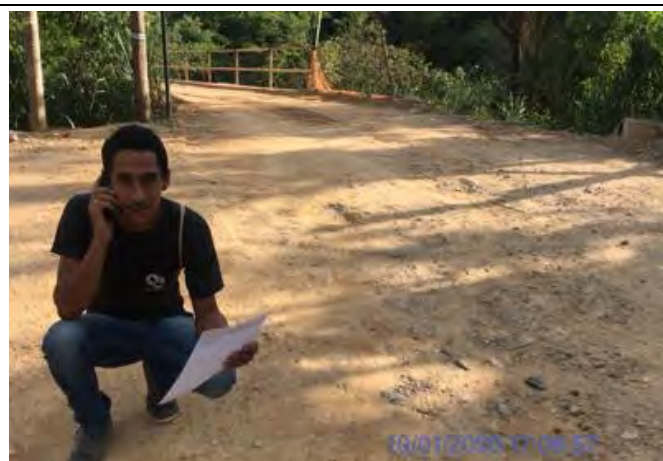
Foto 12 – Motorista da ADA aguardando o desbloqueio da estrada após a conclusão da atividade de desmorte de rocha (10/01/2020).
