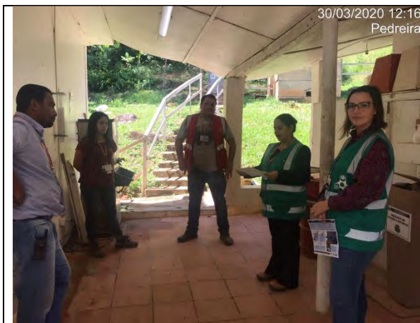
Foto 13 – Roda de conversa nas frentes de trabalho – Segurança do Trabalho (30/03/20).
